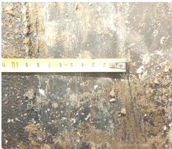
Slika 6: Pogled na preklap hidroizolacije
