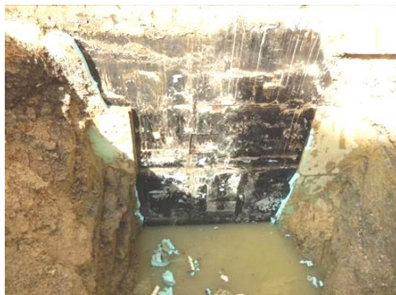
Sliki 3 in 4: Risba sondažnega izkopa in pogled na izvedeni sondažni izkop T1 ob AB obodni vkopani steni
