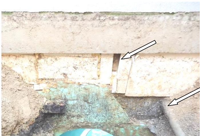
Slika 5: Pogled na mestoma nezaščitenega dela hidroizolacije
