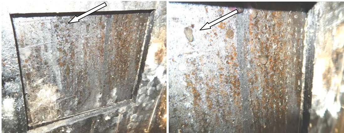
Sliki 7 in 8: Pogled na odstranjen kos hidroizolacije, kje je bila površini AB vkopane obodne stene močno vlažna
