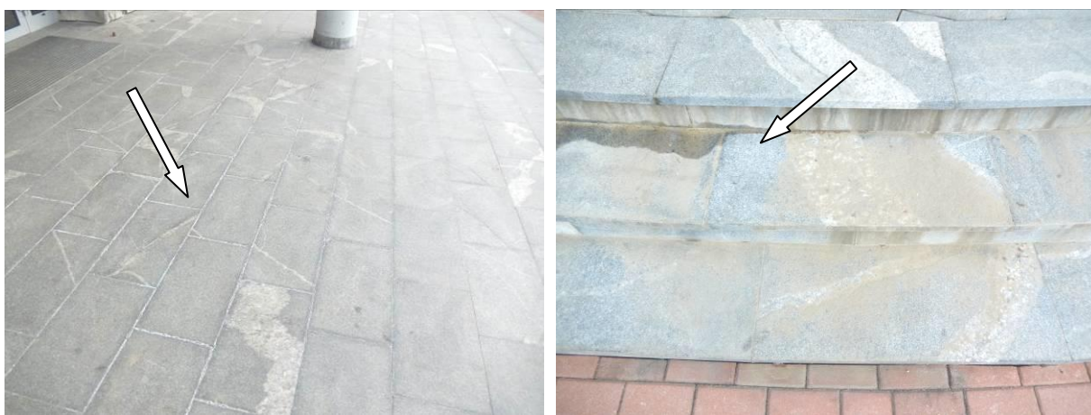
Sliki 11 in 12: Izločanje sige na horizontalni površini terase (slika levo) in sledovi zamakanja in plasti sige na stopnicah (slika desno)
