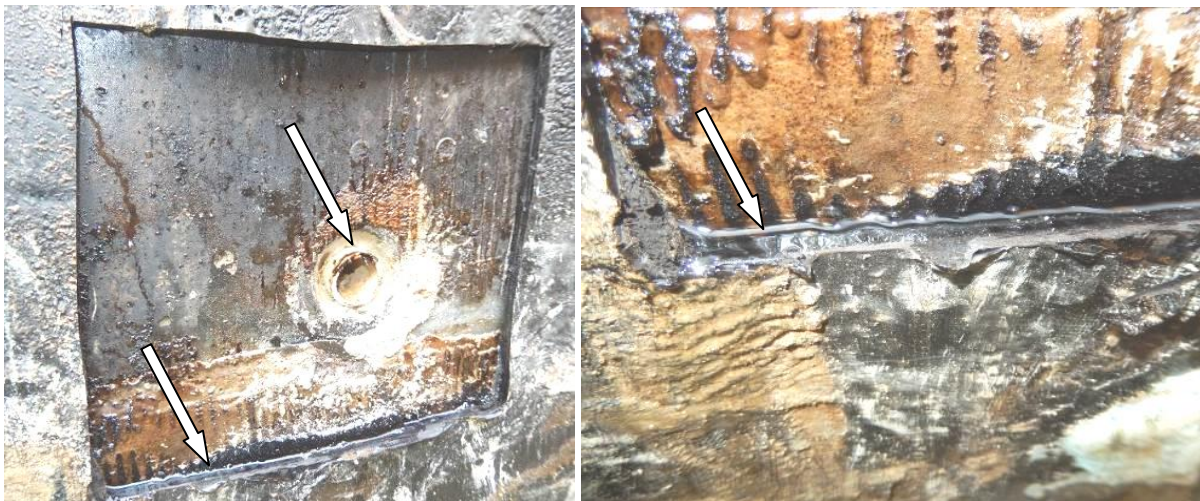
Sliki 9 in 10: Pogled na odstranjen kos hidroizolacije, v področje katerega doteka voda iz stika neodstranjene hidroizolacije in betonske stene. Vidna je tudi nezatesnjena »juvidur« cev
